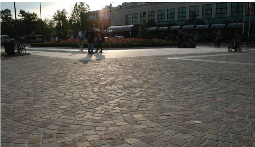
Foto 4. Revestimento de pedra com superfície plana em frente à estação ferroviária de Porta Nuova em Verona (Itália).
